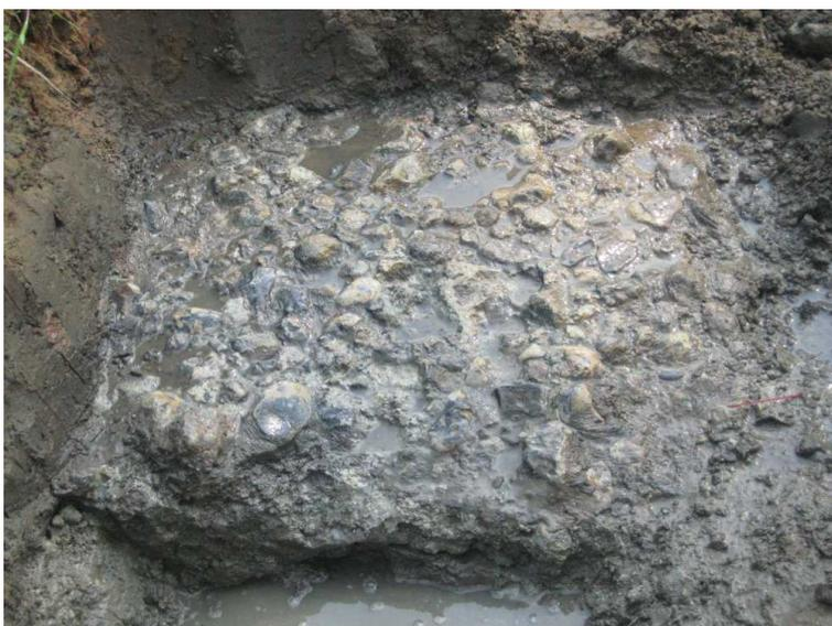
Fig 8 : Empierrement de 15 cm d'épaisseur (10 cm de gros silex et 5 cm de petits silex jointoyés au mortier de chaux maigre)
