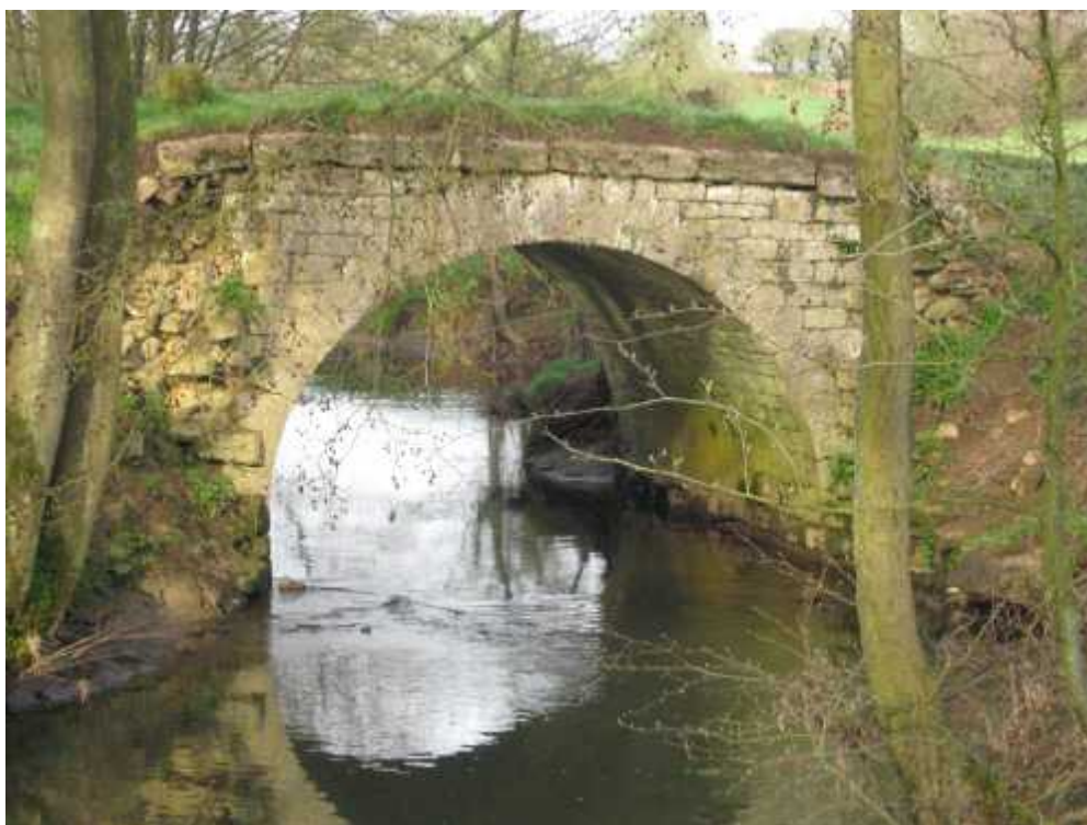
Fig.1 : Vue générale du Pont de Coq depuis le Sud-Est – Cliché ASPC – PFT 04/04/2011
